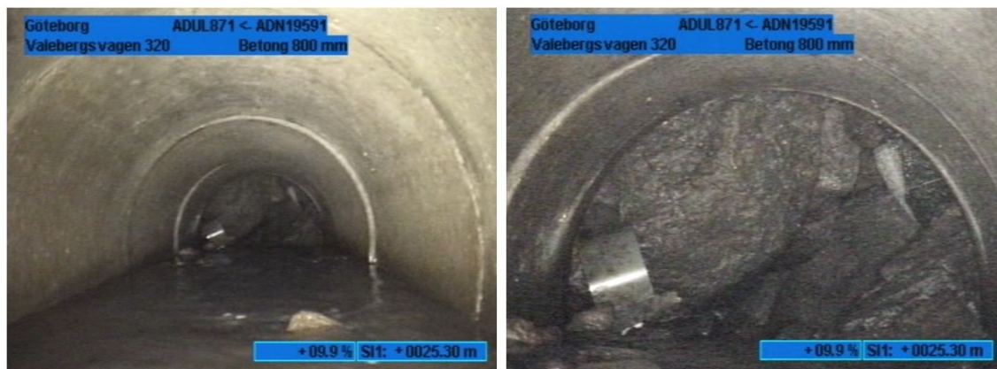
Figur 8 Bild från filmning av dagvattenledning. Visar utlopp 1.
