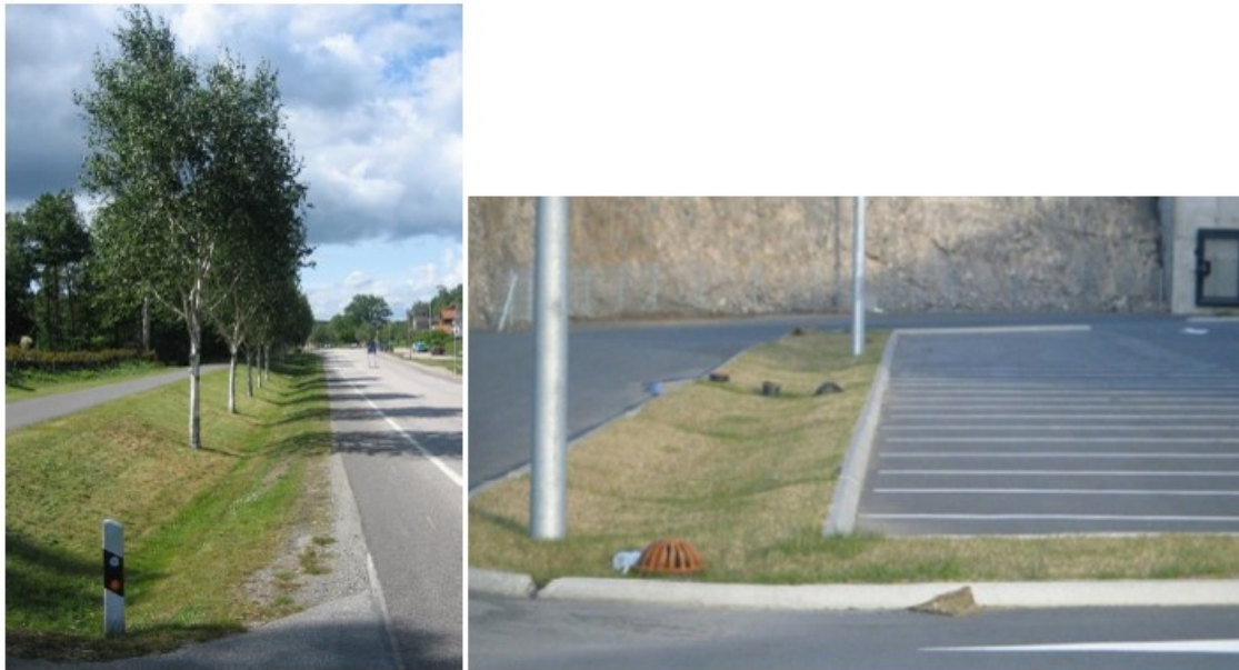
Figur 19 Svackdiken. Till höger svackdike med stensatt kant och kupolbrunn
